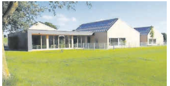
Kindergarten Neubau Primisweiler
